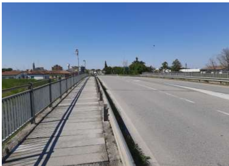
Figura 9: vista del ponte esistente – manto stradale, securvia e particolare cordolo da rimuovere.
