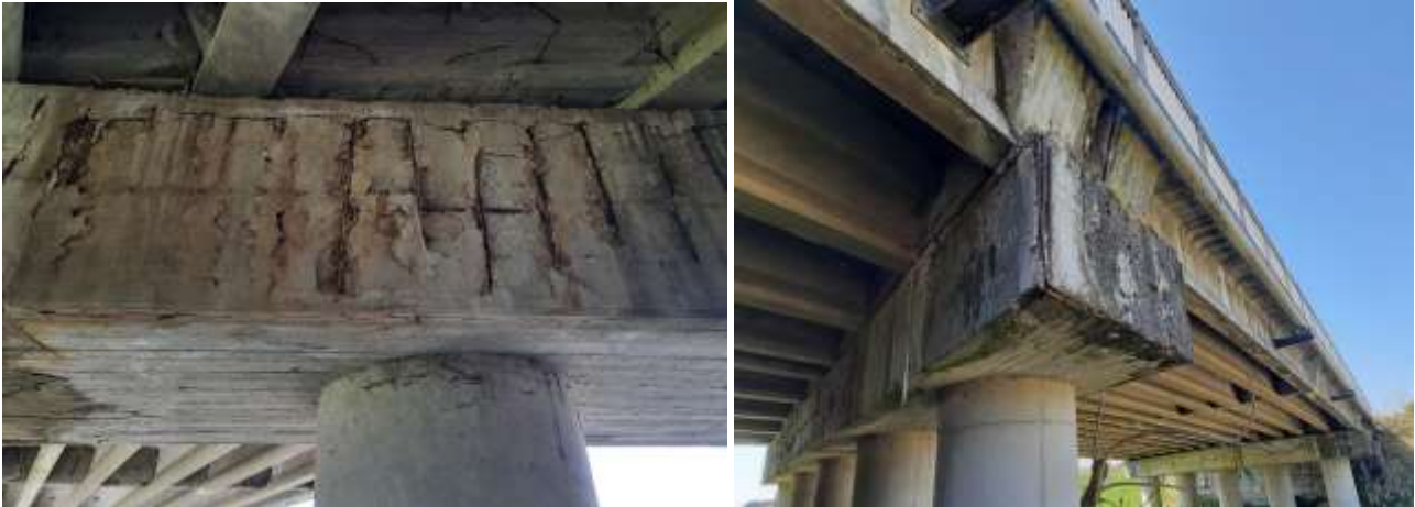
Figura 13: Vista dello stato di fatto dei Pulvini
