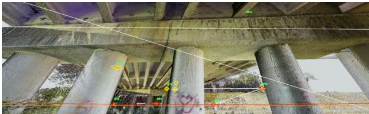
Figura 4: nuvola di punti, vista intradosso, discontinuità.
