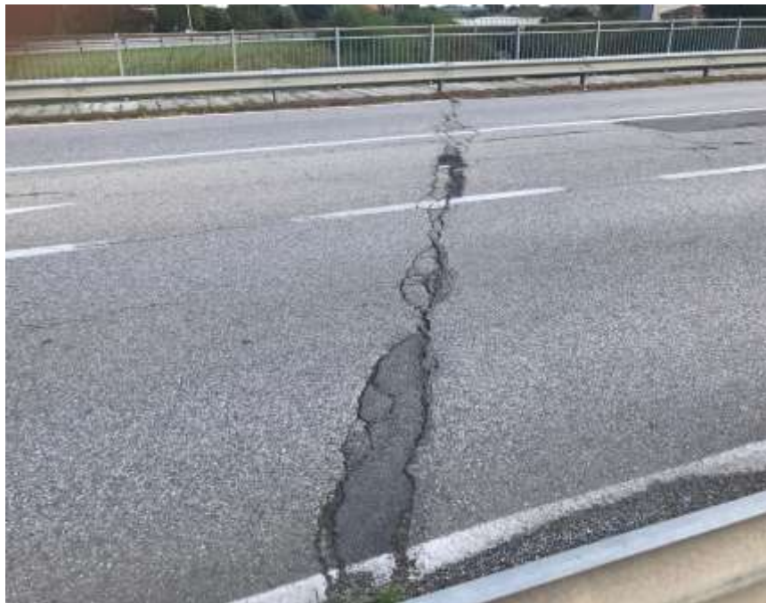
Figura 10: vista del ponte esistente: Giunto su Pile oggetto di intervento di collegamento strutturale
